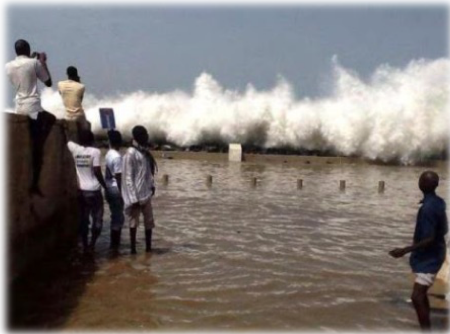
Photo 6 : Déferlement des vagues au niveau de Rufisque – Sénégal (Digue de protection de Thiawlène) Source : MOLOA, 2016
