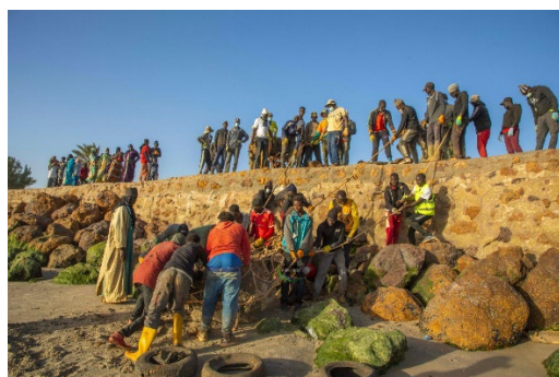
Figure 7 : Pose de matériaux de construction
