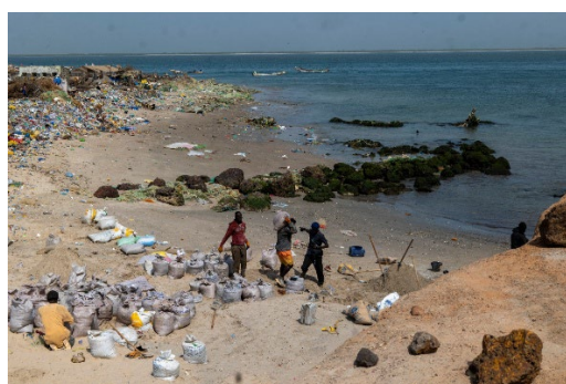
Figure 8 : Des habitations et des portions de plages protégées
